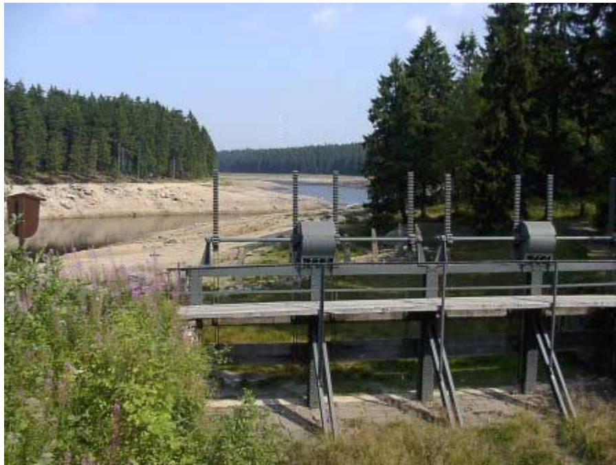
Blick über die Hochwasserentlastungsanlage auf den weitgehend entleerten Stauraum des Oderteiches
