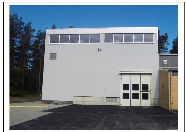
Neues Betriebsgebäude für die Entsäuerung und Flockung
