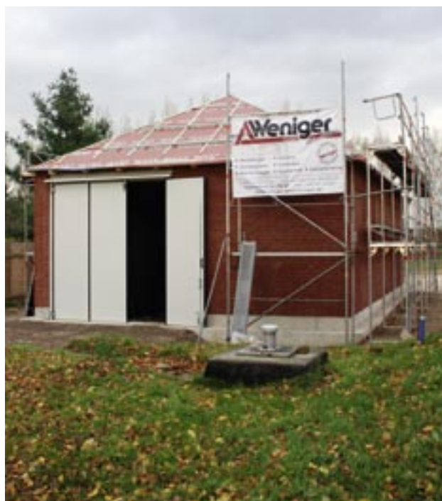
Der Neubau wird im Frühjahr 2009 fertig gestellt sein
