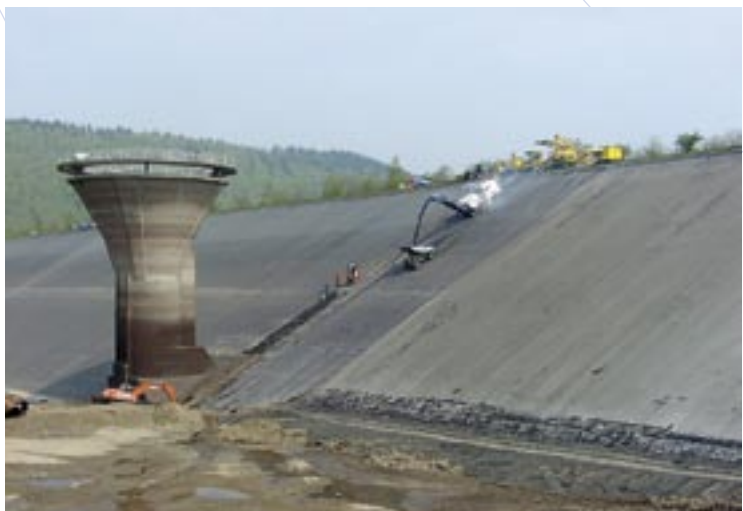
Fräsarbeiten an der Asphaltbetondichtung
