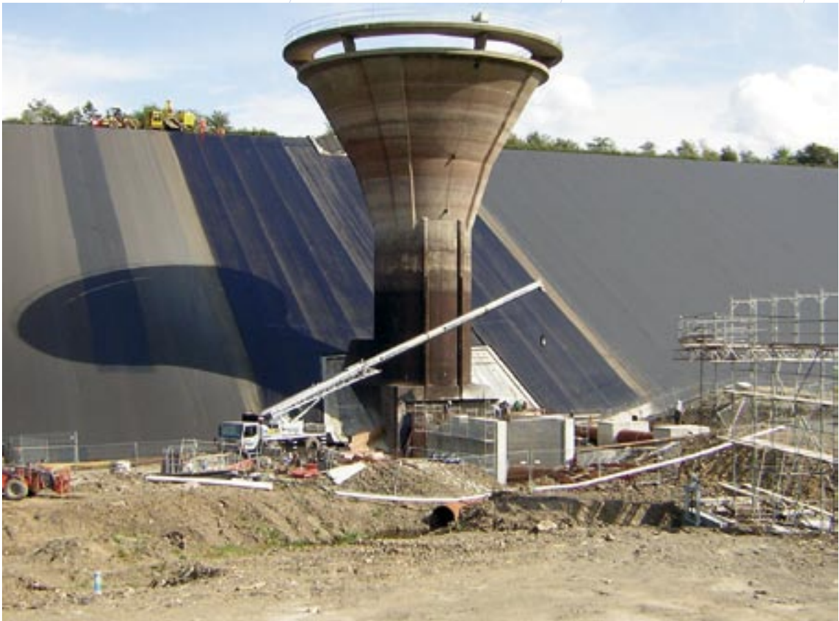
Umbau der Grundablasskammer
