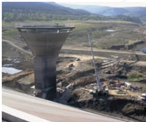
Baufeld im Bereich des Hochwasserentlastungsturmes
