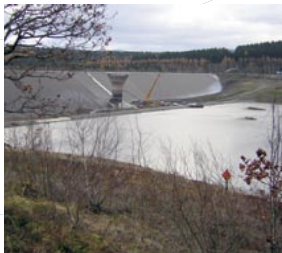
Einbau des Hochwasserschutzdammes
