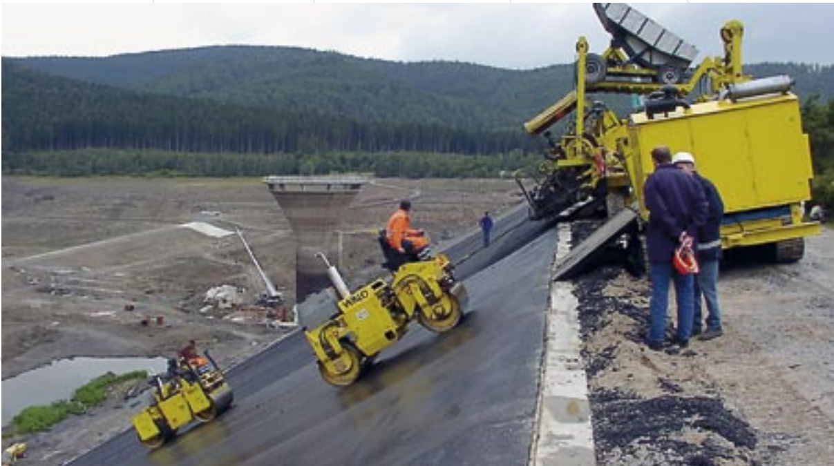
Aufbringen der neuen Asphaltbetondeckung
