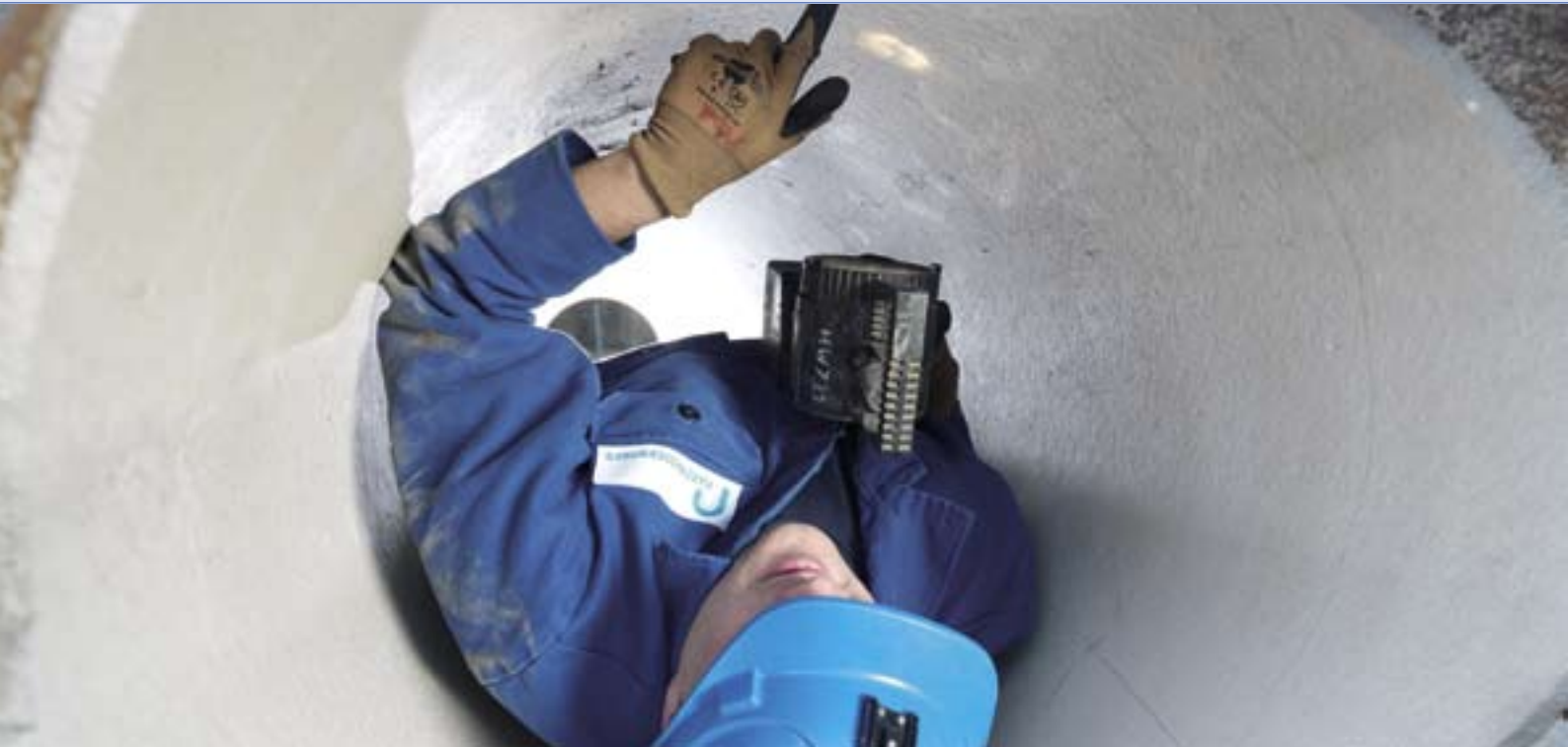
Ein Mitarbeiter der Harzwasserwerke GmbH inspiziert die Zementmörtelauskleidung einer Wasserleitung.
