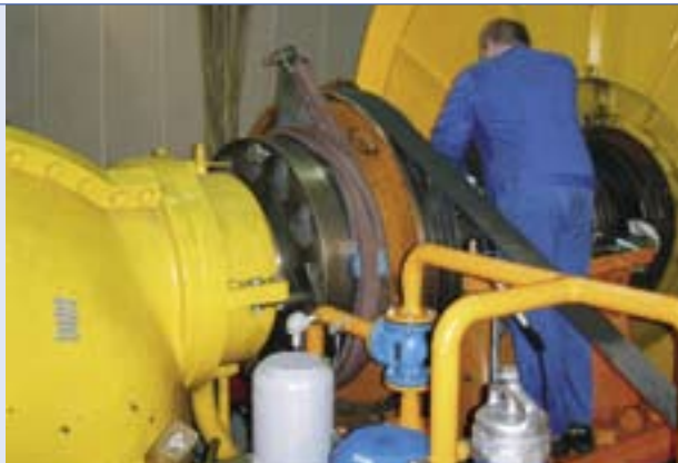
Revision am Turbinenlager im Kraftwerk an der Odertalsperre.
