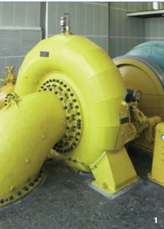
Turbinen laufen in allen Kraftwerken auf Hochtouren: Zu sehen sind hier Turbinen im Wasserkraftwerk an der Okertalsperre (1), im Hochbehälter Wolfstein (2) und die neue (3), beziehungsweise alte Turbine mit Generator im Wasserwerk an der Eckertalsperre (4).
