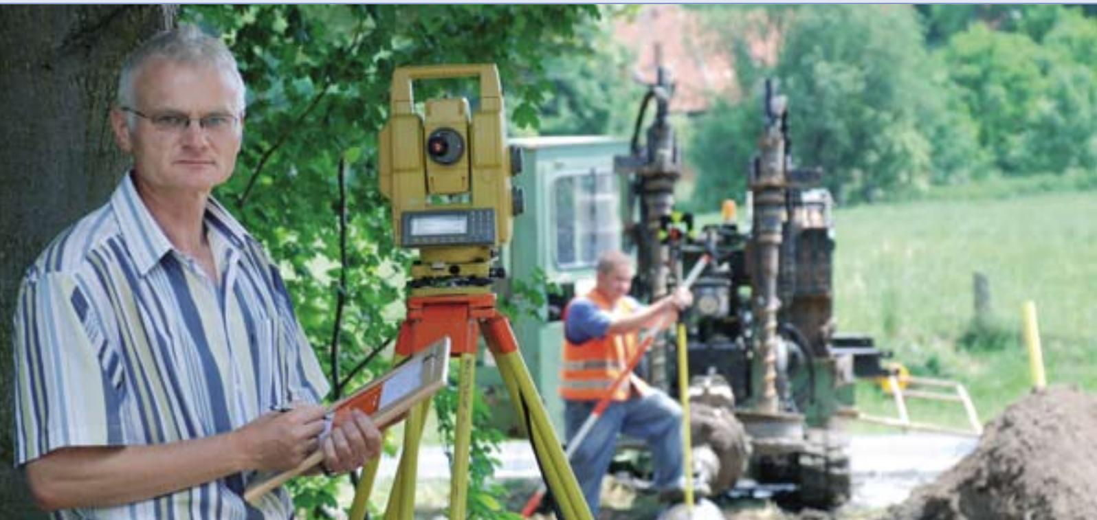
*Baubegleitende Vermessung beim Neubau einer Trinkwassertransportleitung.*
