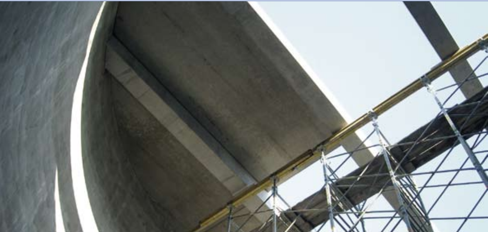
Dachkonstruktion des neuen Wasserhochbehälters in Groß Brunnsrode.
